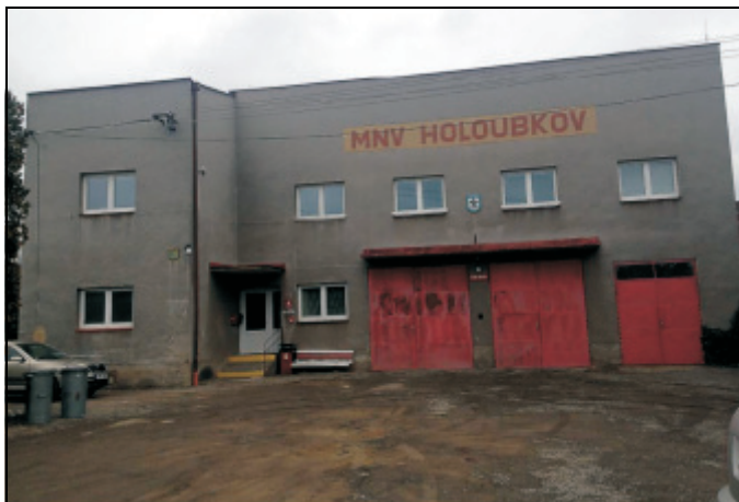
Hasičská zbrojnice před opravou
