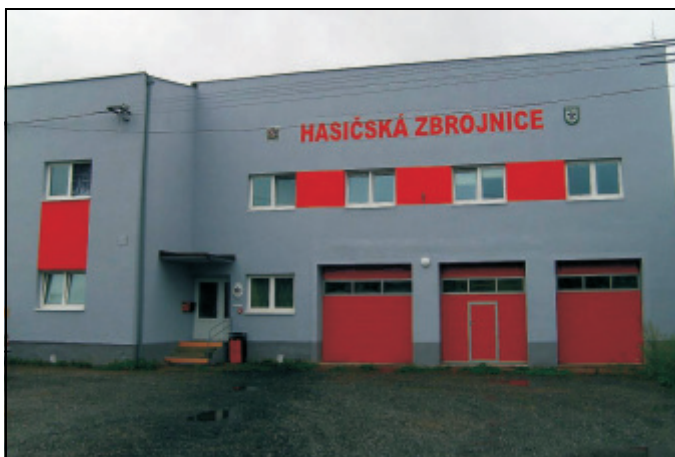
Hasičská zbrojnice po opravě
